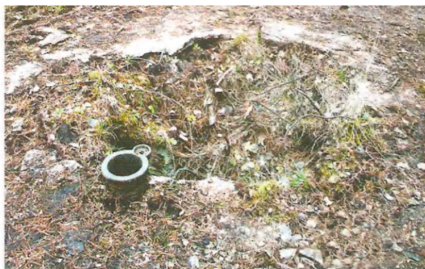
ОППК № 10 со следами подрыва возле обсадной трубы перископа
