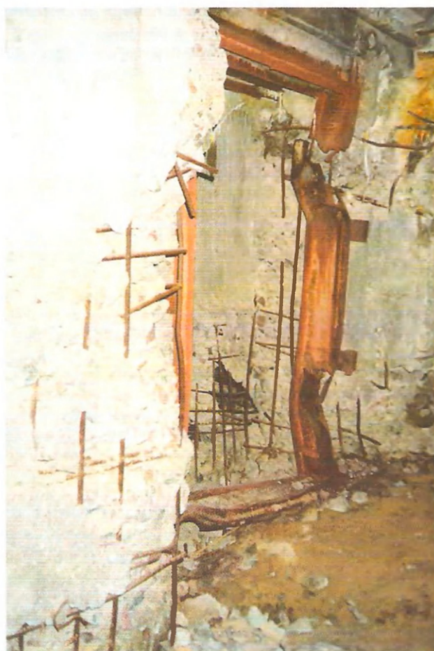
Дверной проем ДОТа № 38 со следами подрыва
