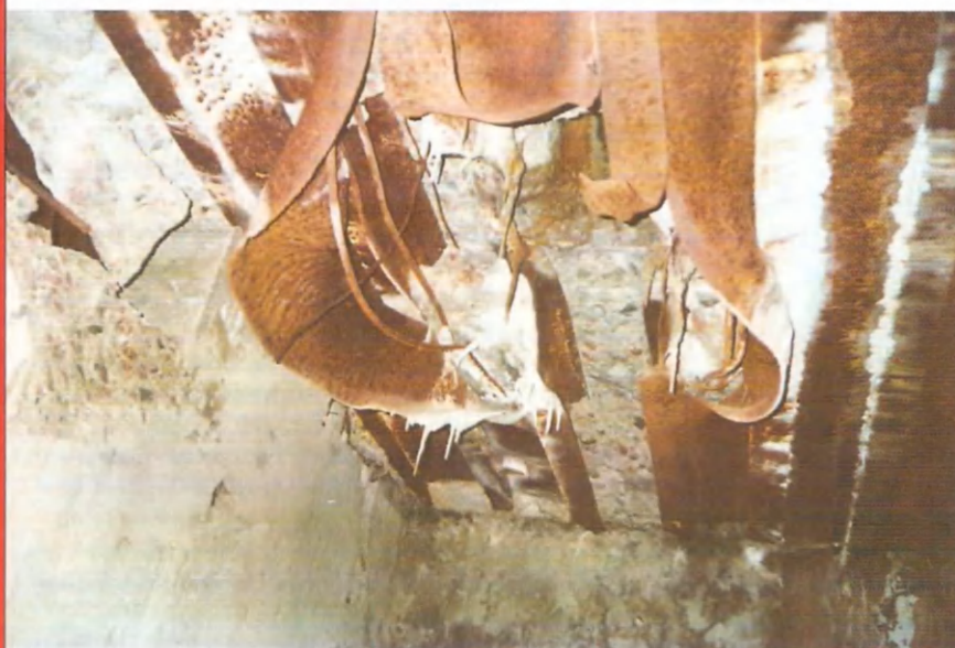
Обсадная труба перископа ОППК № 59 со следами подрыва
