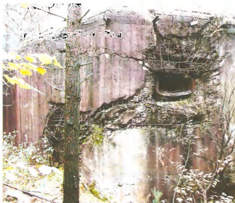
Орудийно-пулеметный ДОТ № 72 со следами подрыва
