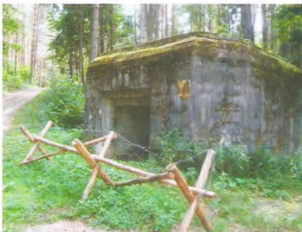
Упрощенный ГДОТ № 10а на берегу Августовского канала
