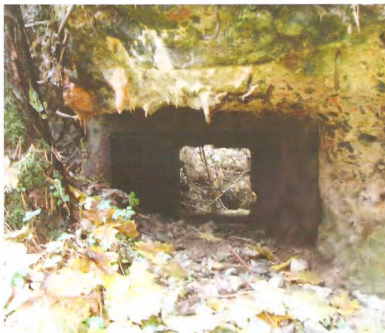
ДОТ № 15. Амбразура установки ДОТ-4 со следами стрельбы 88 мм зенитными снарядом
